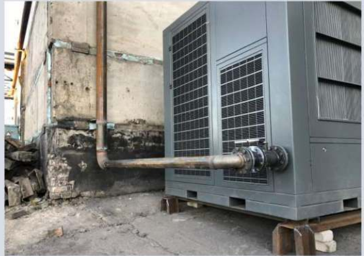
ООО «Голухинский цемент», монтаж и пусконаладка
