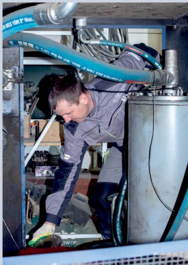
Ремонт компрессора «Airpol»
